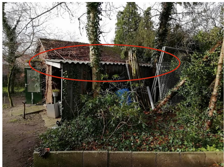
Afbeelding 2 en 3: Dak opgebouwd uit 3 materialen, dakpanplaten, singles en golfplaten. Bron: Rik Bijvelds, 26-02-2020
