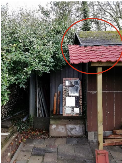
Afbeelding 2 en 3: Dak opgebouwd uit 3 materialen, dakpanplaten, singles en golfplaten. Bron: Rik Bijvelds, 26-02-2020
