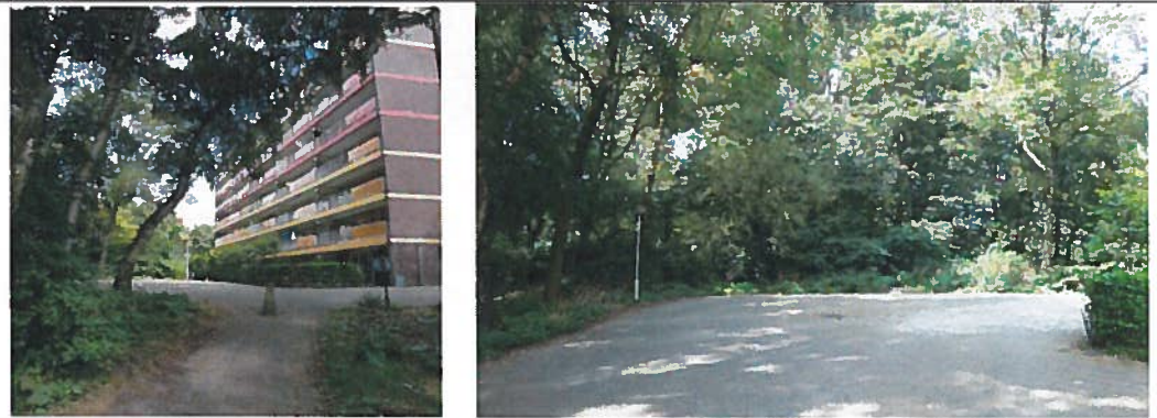
Portiekflat Haagsebos achterzijde en locatie extra bedrijfsingang
