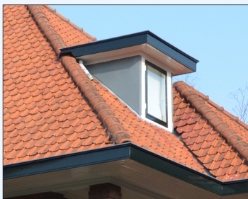
ranke boeidelen met slanke daktrim en zinken zijwangen
