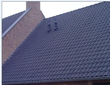
keramische, holle, antraciete dakpan met gesmoorde of mat verglaasde afwerking
