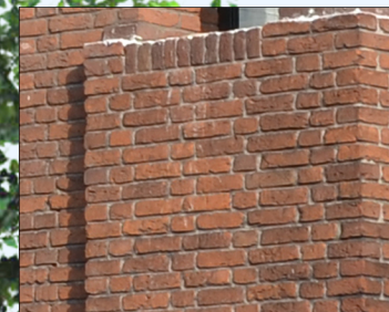
genuanceerd metselwerk in warme oranjebruine kleur, handvorm, verdiepte voegen, in kettingverband, plint idem, maar in donkerbruin
