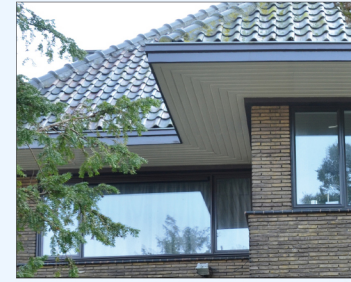
grote, ranke dakoverstekken, witte gootplafonds van in verstek gezaagde kraaldelen
