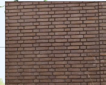
tweede kleur: genuanceerd mestelwerk in stoere roodbruine kleur, handvorm, verdiepte voegen in kettingverband, plint idem
