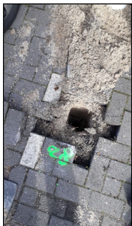
Foto 31: Deellocatie 1B, proefgat 028
