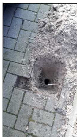
Foto 30: Deellocatie 1B, proefgat 025
