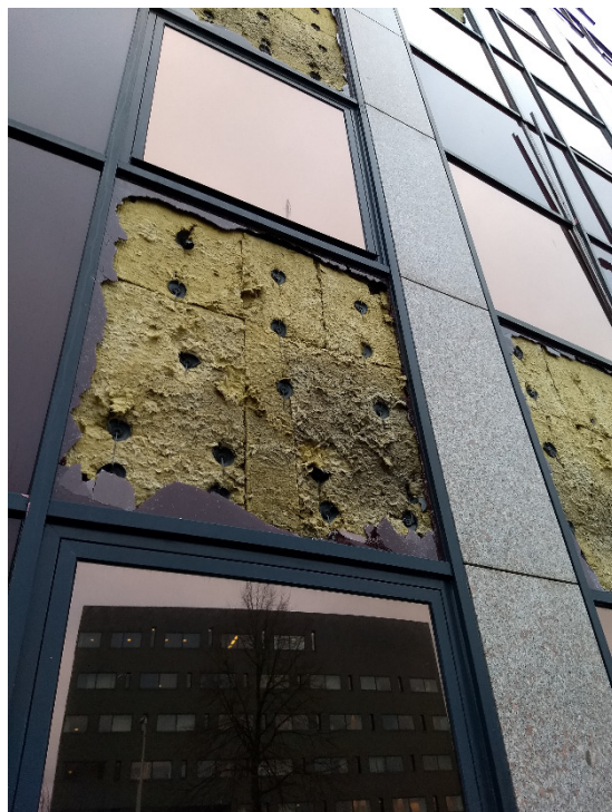
Impressie van de te slopen bebouwing met marmeren beplating en isolatiemateriaal blootgelegd (onder)
