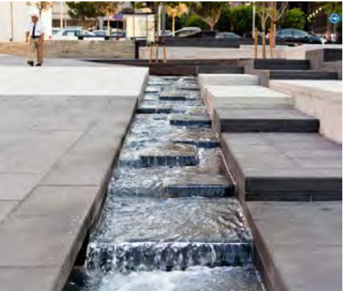
Watercascades maken afvoer hemelwater zichtbaar
