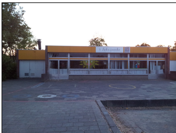
Figuur 2. Schoolgebouw 't Schrijverke
