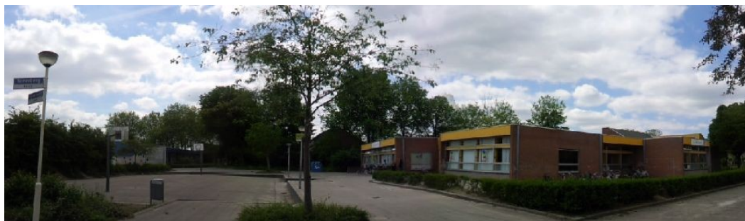
f2.2 Aanzicht plangebied in de situatie waarbij het voormalige gebouw nog aanwezig was
