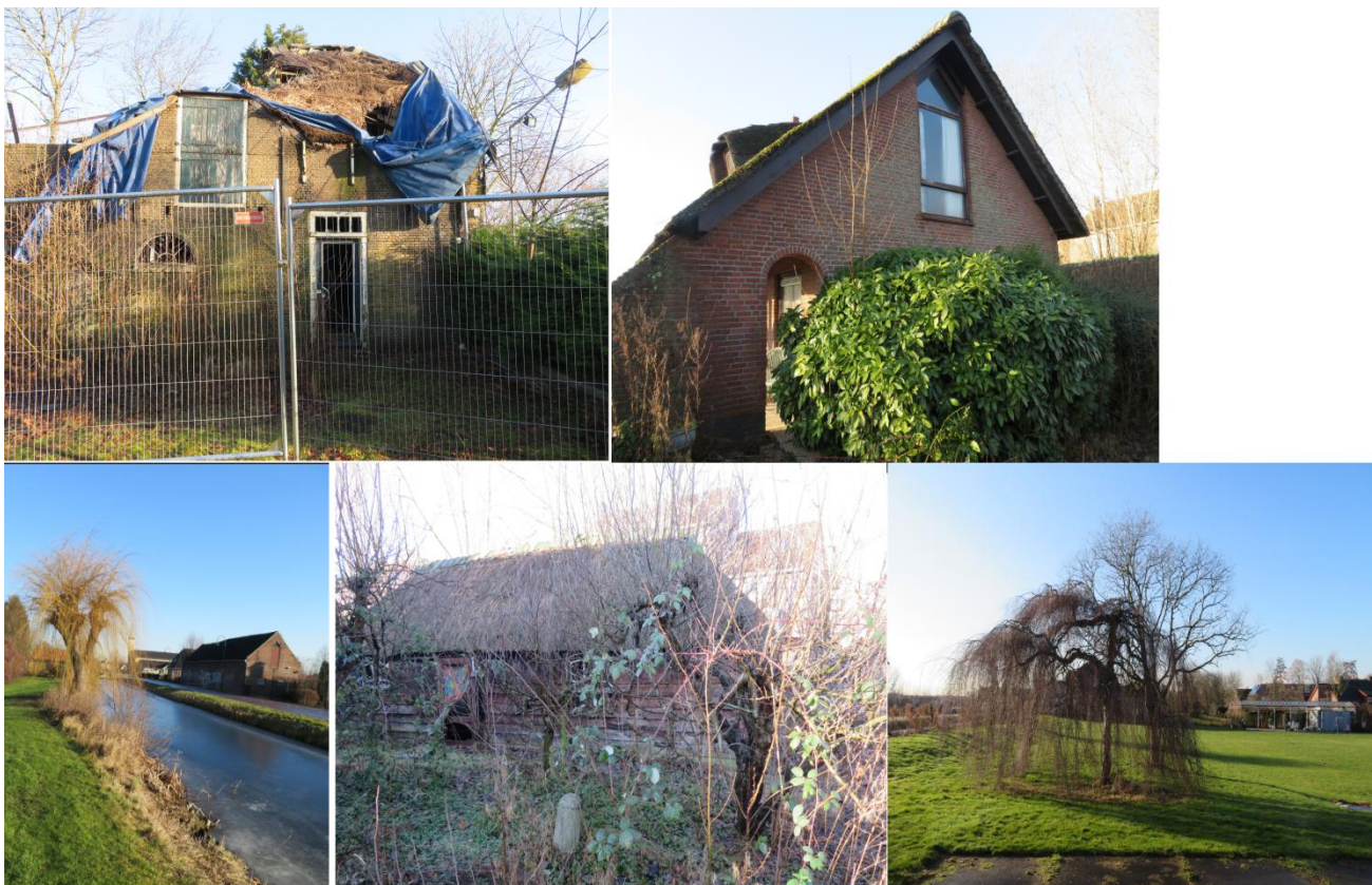
Fig. 2.: Foto-impressie plangebied, met linksboven de vervallen hoeve en rechtsboven het woonhuis. Linksonder het zicht op de Zegwaartse wetting met de treurwilg (waarvan detail in de foto rechtsonder), onder in het midden de monumentale schuur
