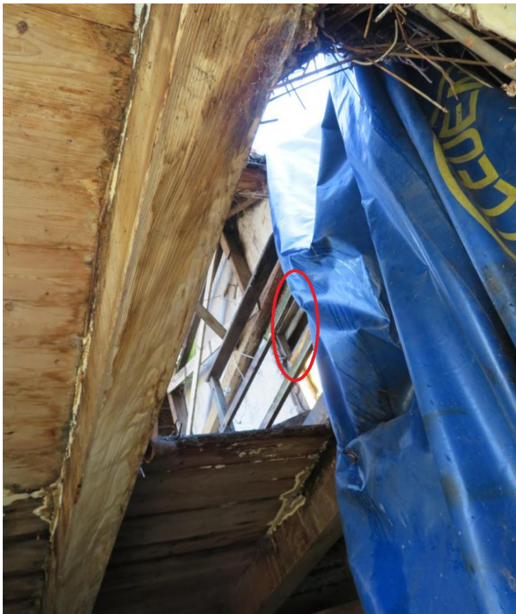
Fig. 6.: Foto-detail van de binnenkant van de voormuur van de Leeuwenhoeve
