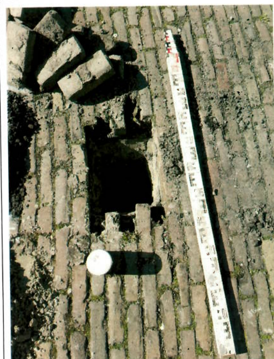
Asbest inspectiegat 02
