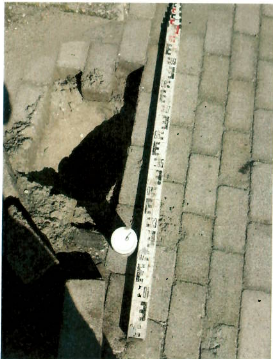
Asbest inspectiegat 06
