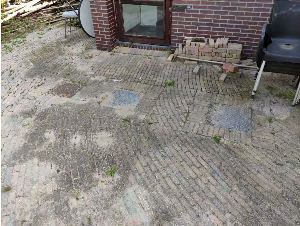
Figuur 1 Vetafscheider met stankdichte deksels (foto vanuit terreinverkenning)
