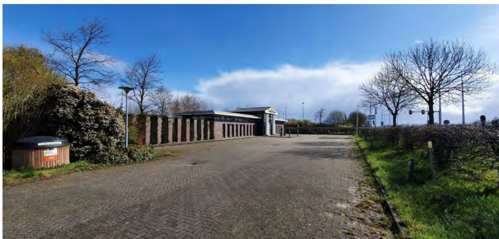
Impressie van het plangebied gezien vanaf het parkeerterrein. Foto: K. de Vries / Ecoresult B.V.
