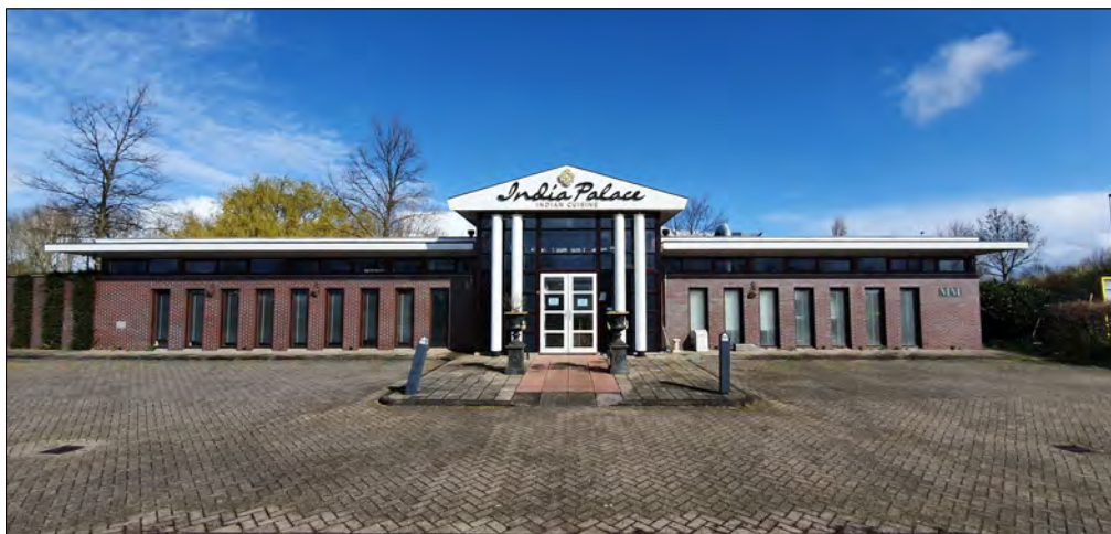
Afbeelding 3: Het pand waarin restaurant "Indian Palace" in is gevestigd. Foto: K. de Vries | Ecoresult B.V.
