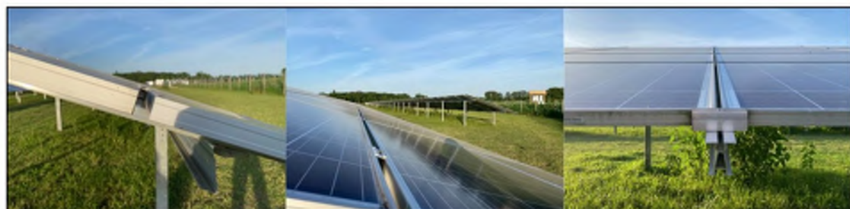
Afbeelding 25. Opstelling pv-panelen, waardoor voldoende ruimte is voor infiltratie regenwater (bron: Eelerwoude/TR).
