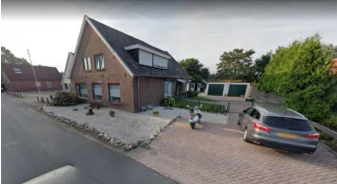
Figuur 2.4: Huidige situatie Roedensestraat 23 te Horssen, gezien vanaf de westkant.
