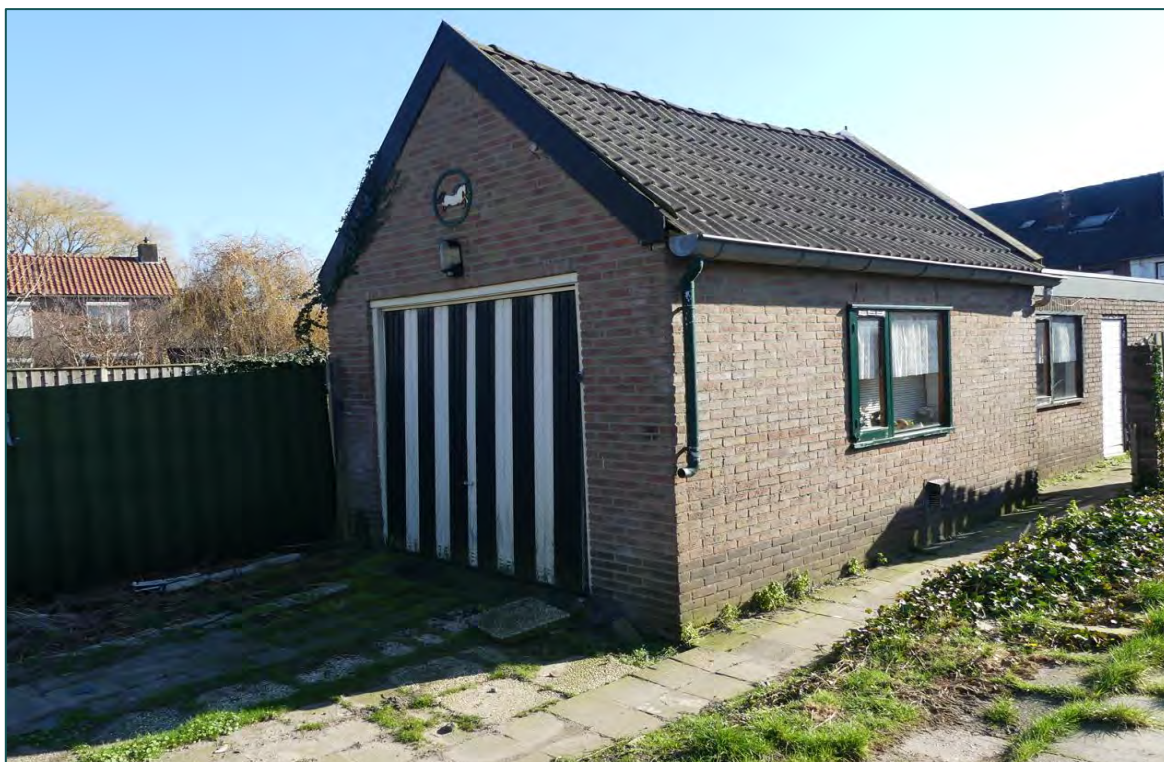
Figuur 2 De bebouwing betreft 3 schuren en een tuinhuis. Het dak van het tuinhuis heeft ruimte tussen dakgoot en dakpannen, hierdoor kunnen huismussen toegang krijgen tot het dakbeschot.
