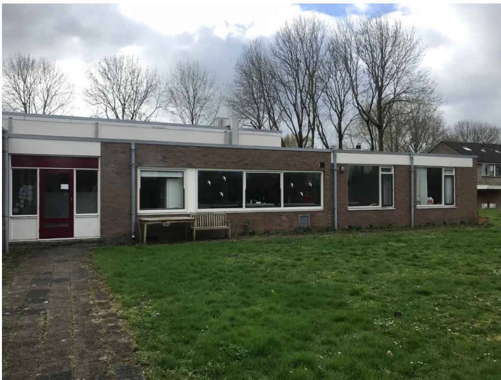
Figuur 3 Het gebouw aan de Hitteschild 6 en bestaat uit gemetselde, geïsoleerde spouwmuren met een plat dak met bitumen dakbedekking.
