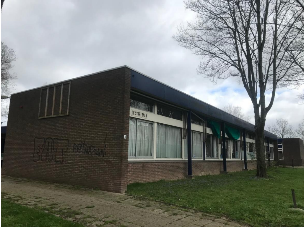
Figuur 1 Het gebouw aan Hitteschild 4 bestaat uit gemetselde, geïsoleerde spouwmuren met een plat dak met bitumen dakbedekking.
