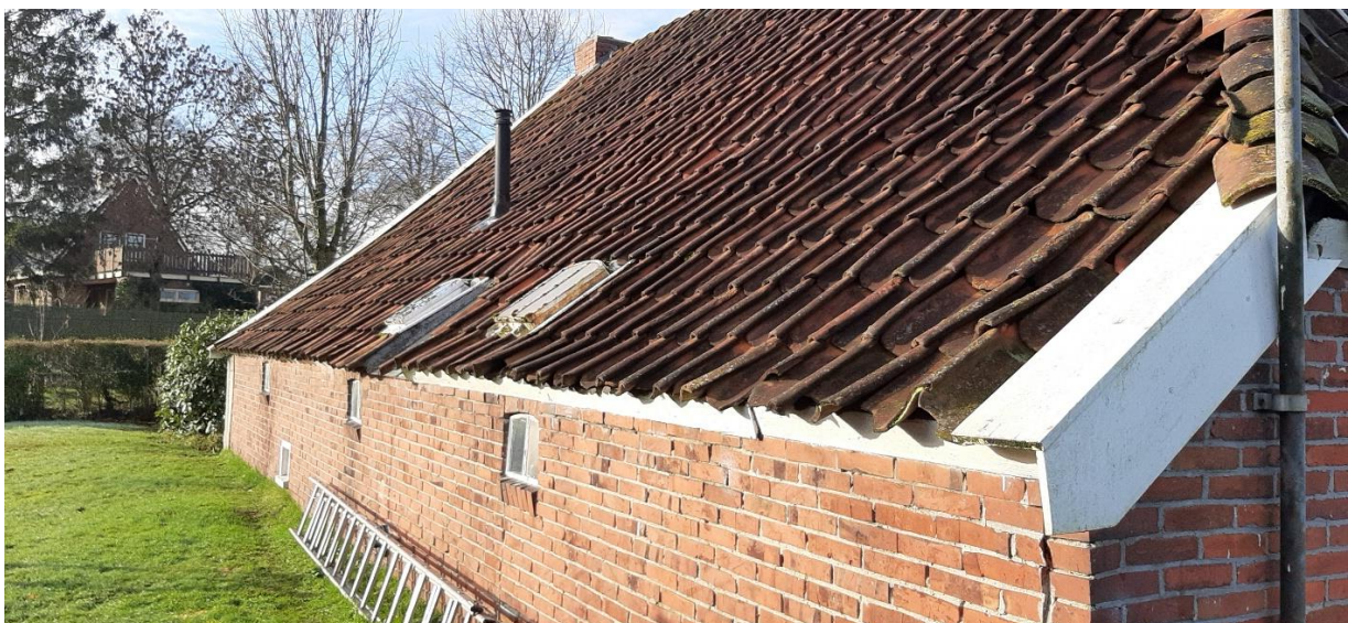
Rechterzijgevel met oorspronkelijk metselwerk en stalen stalramen
