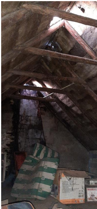
Kapconstructie met afwerking met gaas, bitumenpapier en pannen
