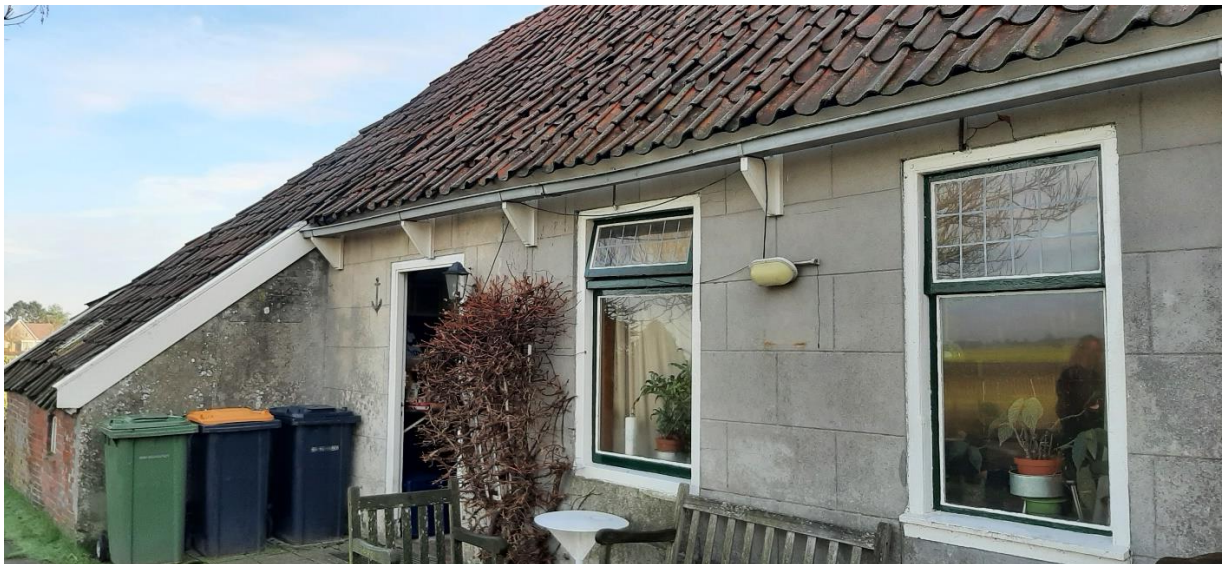
Linkerzijgevel met blokstucwerk en goot met gootklossen
