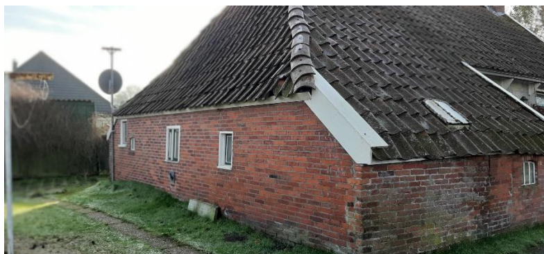
Achtergevel – hoek linkerzijgevel; verschillende raamopeningen
