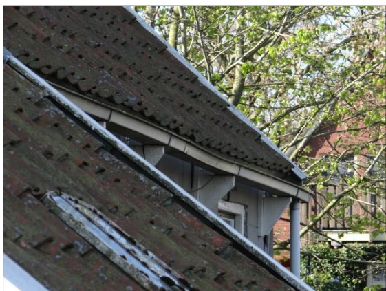
Foto's 5 en 6. Links de dakgoot aan de noordzijde van de woning. Rechts de losse nokpannen op het dak.
