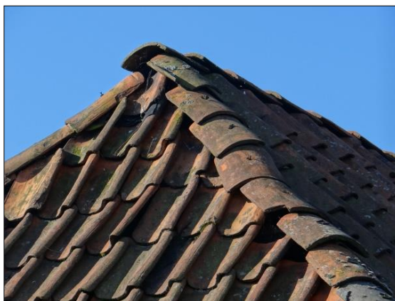
Foto's 5 en 6. Links de dakgoot aan de noordzijde van de woning. Rechts de losse nokpannen op het dak.
