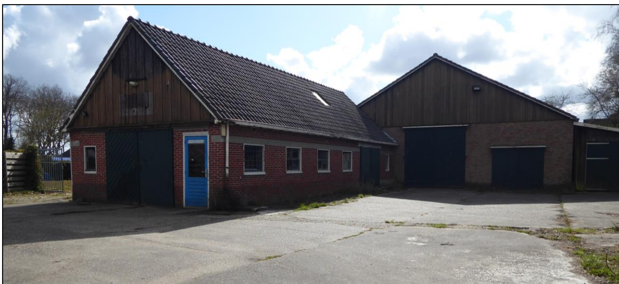
Figuur 1.3. De bebouwing van stationsstraat 3a (deelgebied 2).
