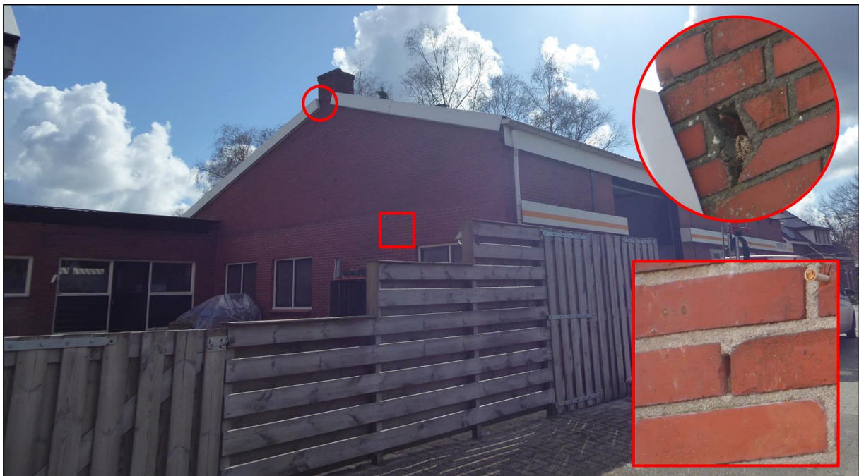
Figuur 2.5. Mogelijke toegangswegen tot verblijfplaatsen voor vleermuizen binnen deelgebied 1.
