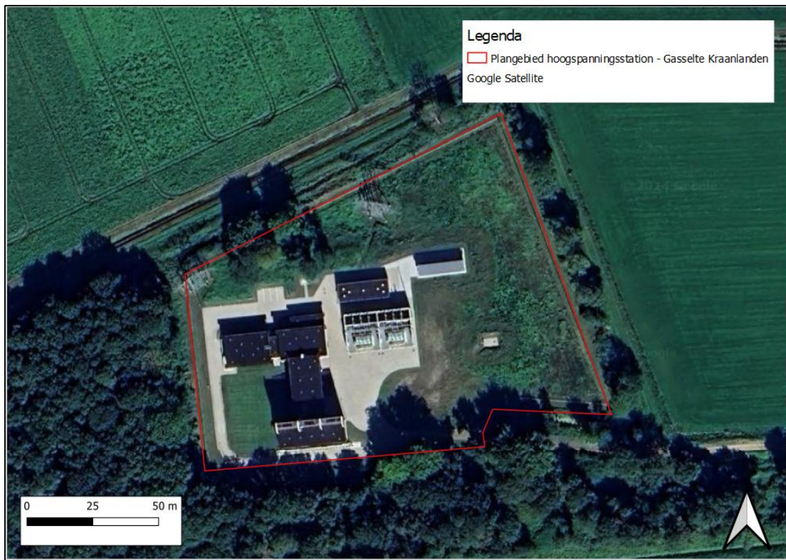
Figuur 2.2.a: Luchtfoto huidige situatie
