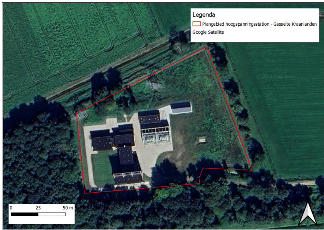
Figuur 2.2.a: Luchtfoto huidige situatie
