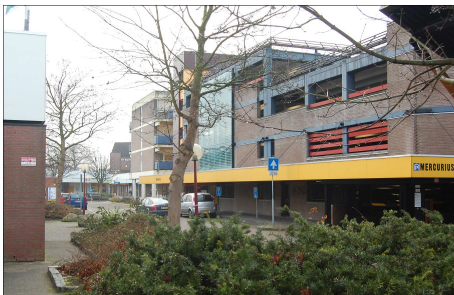
Aanzicht van de parkeergarage en achterzijde van de Minervaflat, gezien vanaf de Minervalaan
