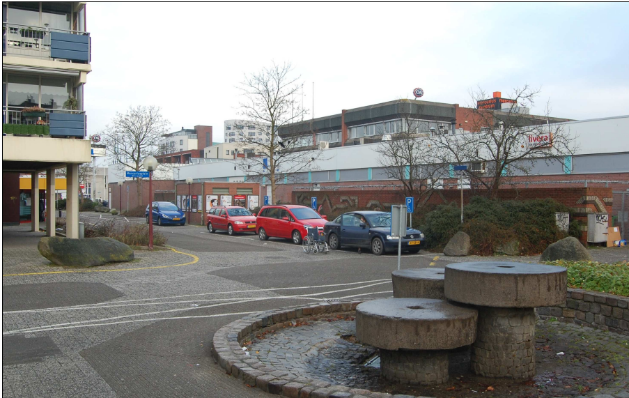
Bestaande situatie bevoorradingsstraat, gezien vanaf het Mercuriusplein
