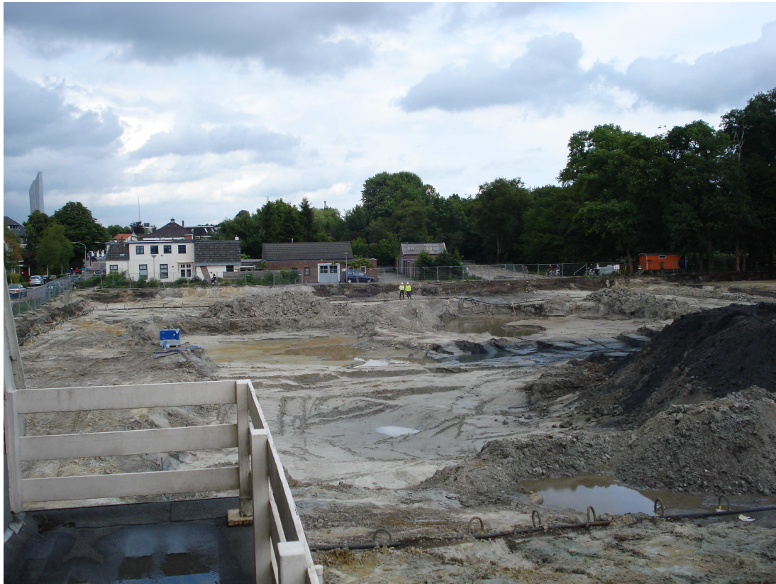
Overzicht sanering gashouders
