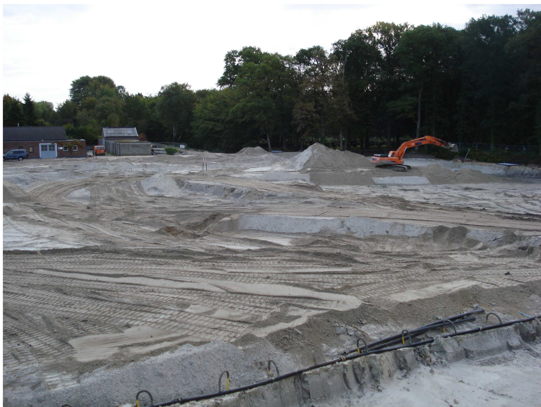
Overzicht na aanvulling gashouders
