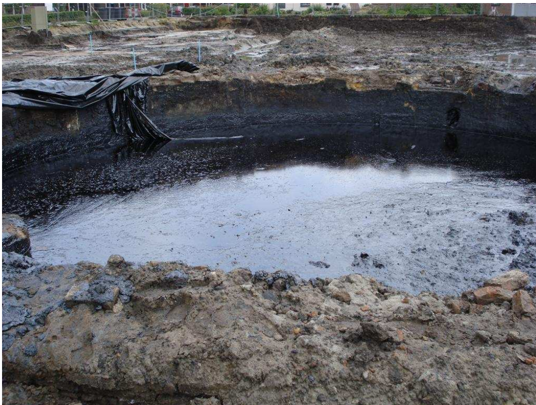
Detailopname gashouder gevuld met teer
