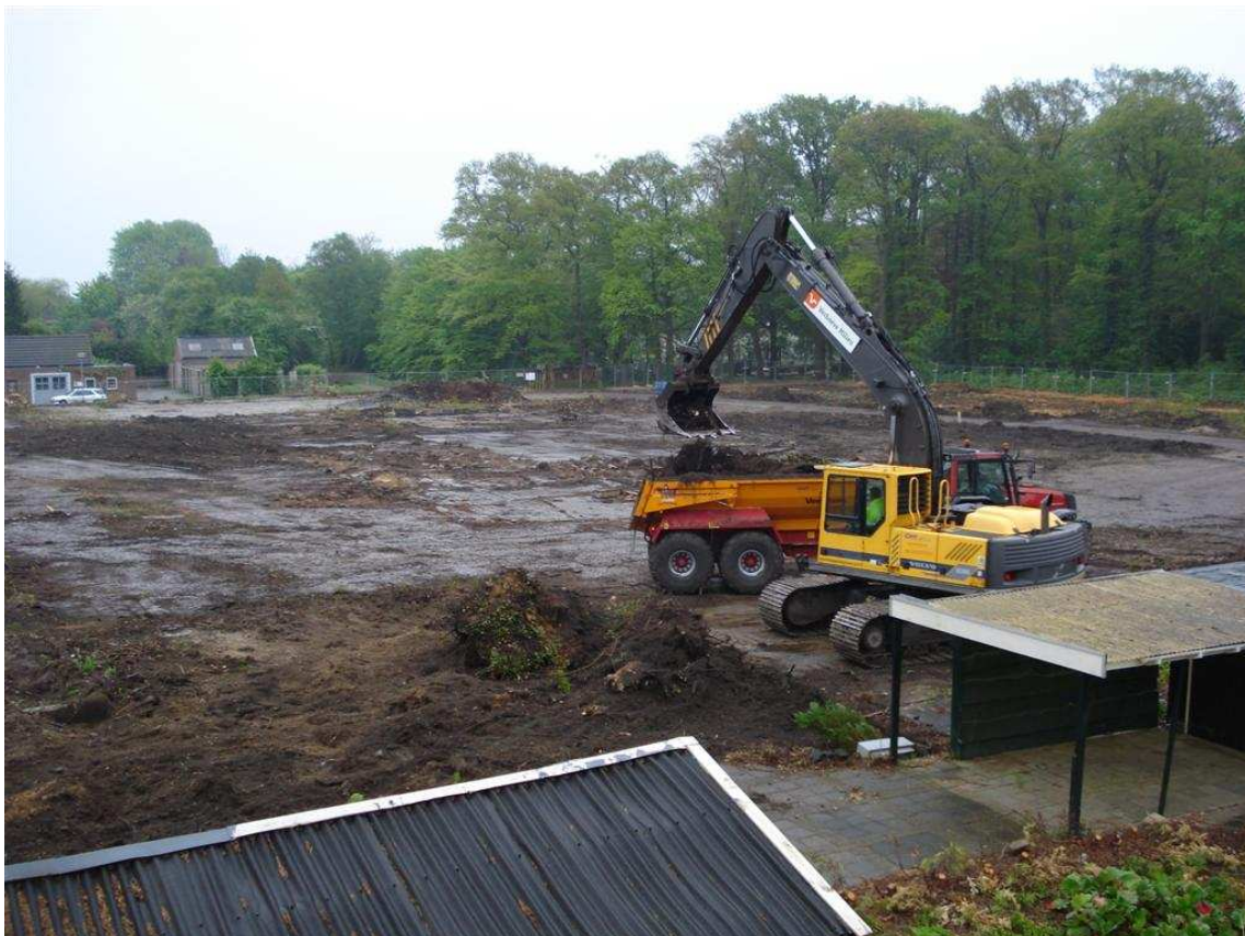
Terrein overzicht richting Goorlaan/ Asserbos na opruimwerkzaamheden
