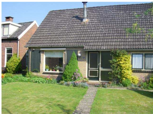
Figuur B1.1 M1 Dakgoot woning Witterstraat 42
