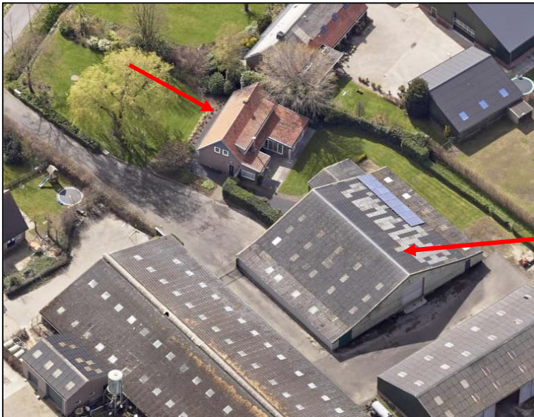
Figuur 6: Naar plattelandswoning om te zetten bedrijfswoning met schuur, aangeduid met rode pijlen, gezien vanuit het noorden (Bron: Slagboom en Peeters)
