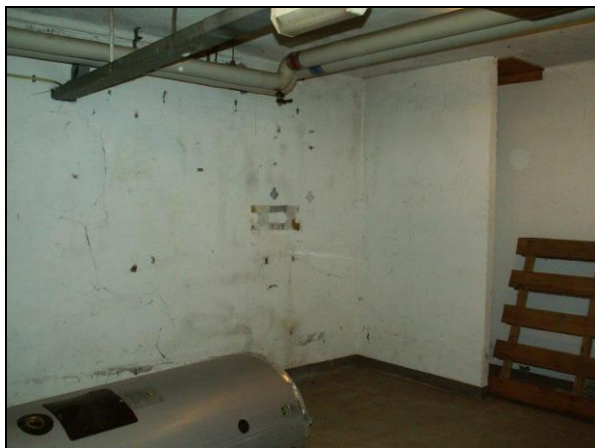
Kelderruimte onder het hoofdgebouw.
