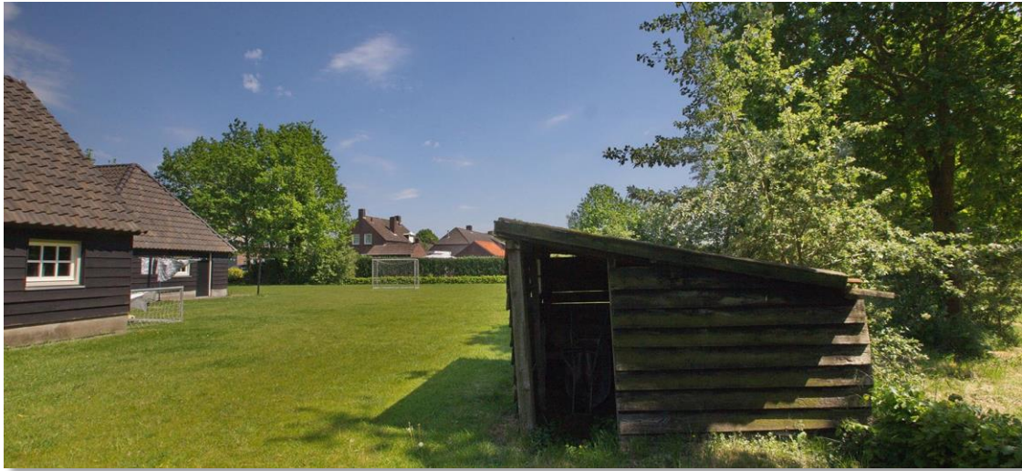
Figuur 7a: overzicht gebouwen vanuit zuid-westelijke richting.
