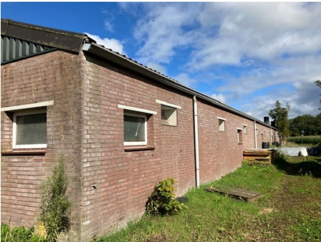
• Afbeelding 10: Zijgevel te slopen stal
