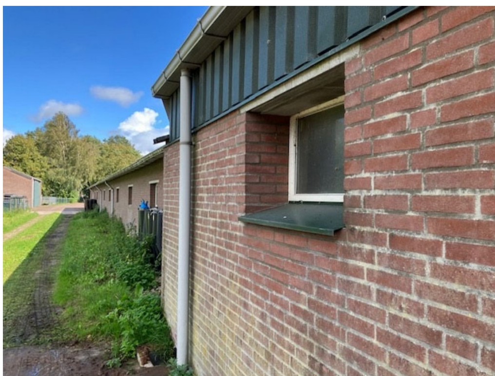
• Afbeelding 17: gevel te slopen varkensstal
