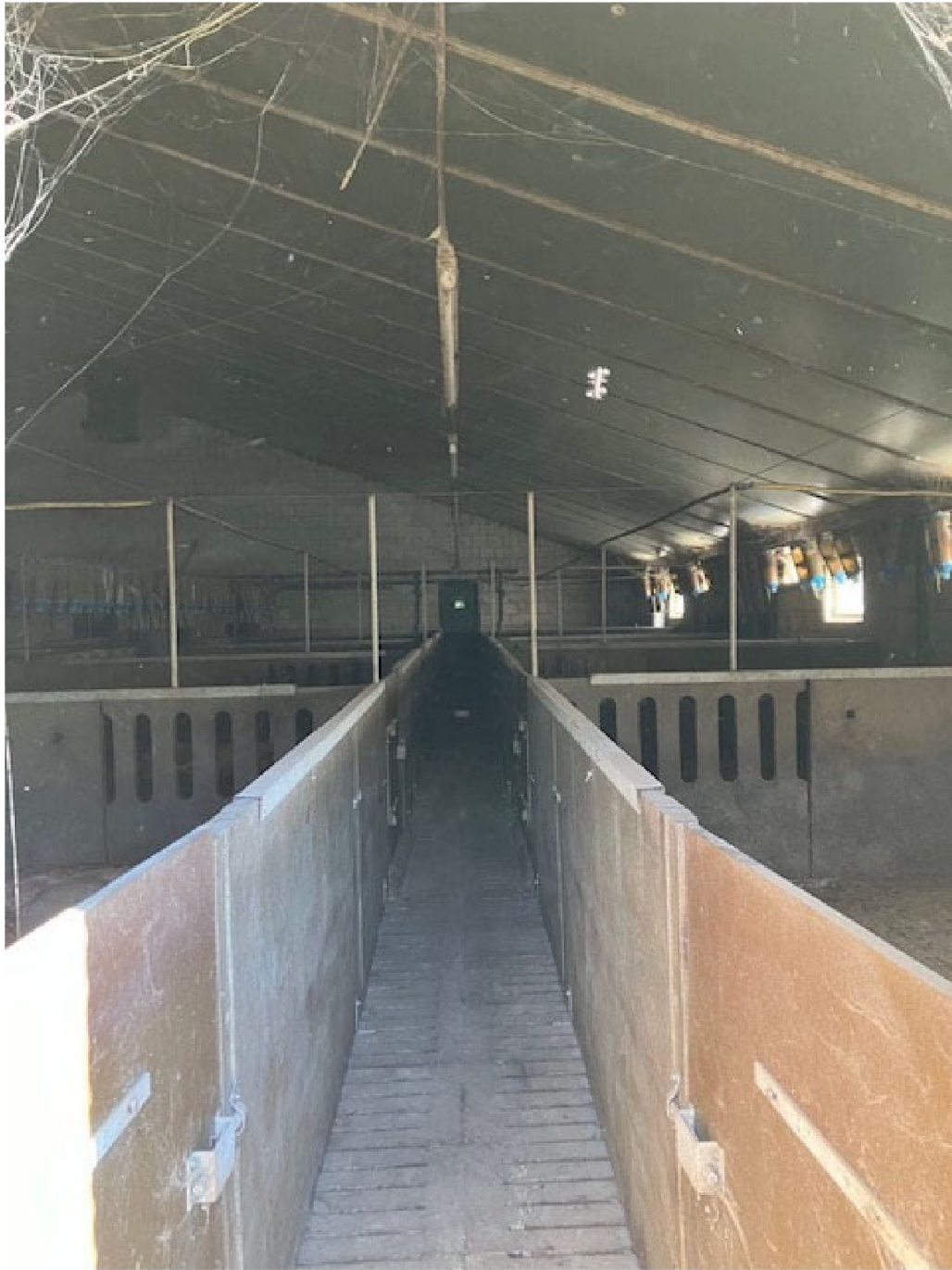
• Afbeelding 11: Binnenzijde stal, de laatste varkens zijn nog aanwezig
