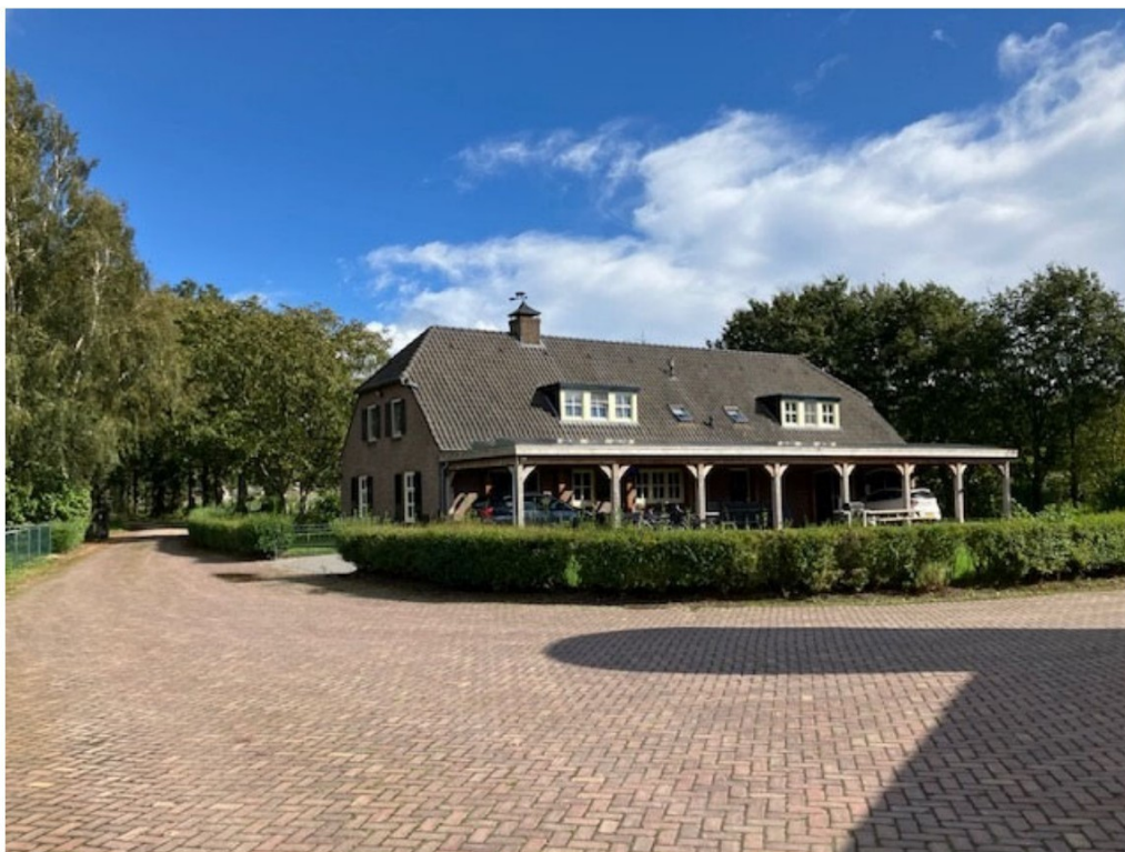
• Afbeelding 20: Achterzijde bedrijfswoning (blijft behouden) met tuin en bestrating
