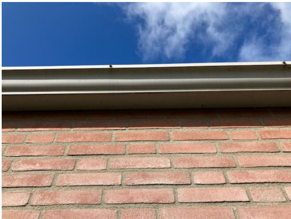
• Afbeelding 8: Detail onderzijde dakgoot, naadloos
