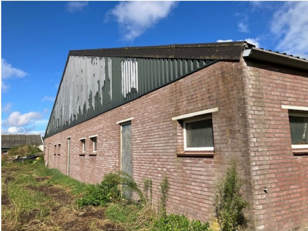
• Afbeelding 9: Achtergevel stal
