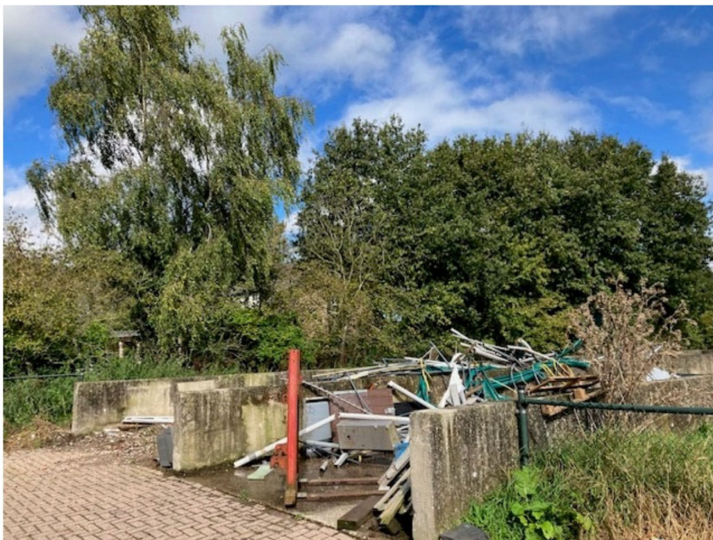
• Afbeelding 5: Sleufsilo's worden verwijderd, beplanting blijft behouden
