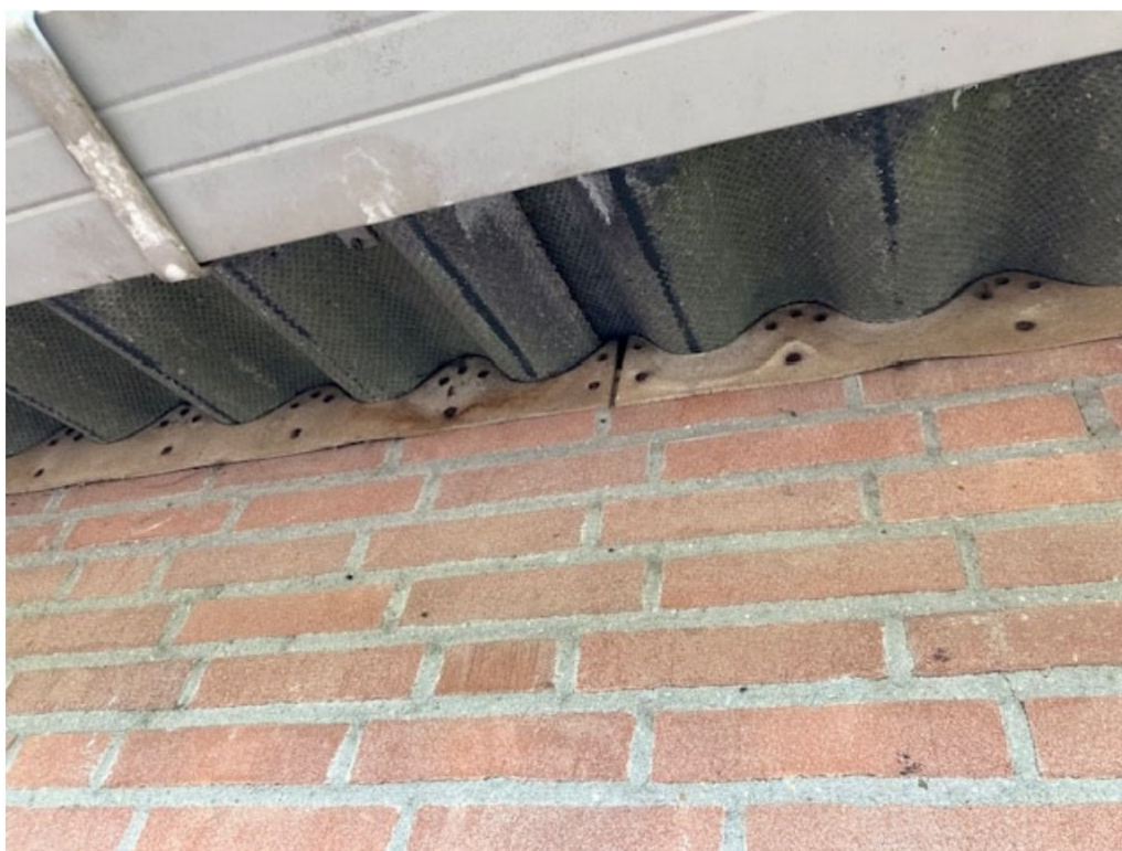
• Afbeelding 18: Onderzijde golfplaten dak, afgewerkt met vogelschroot
