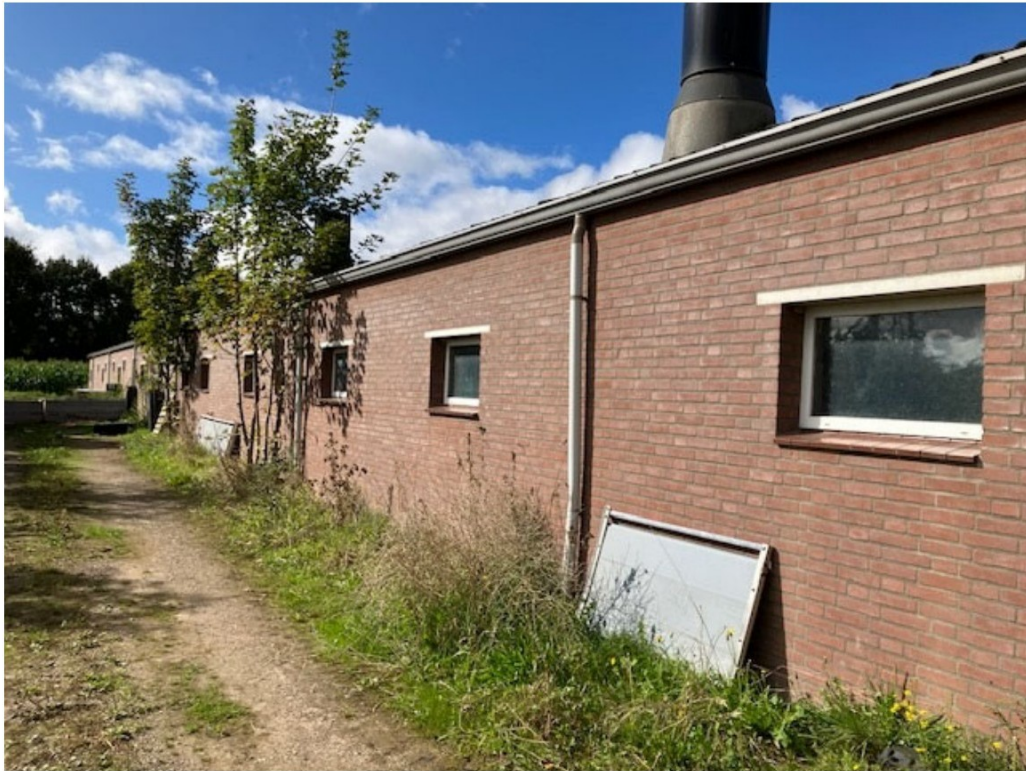
• Afbeelding 7: Zijgevel te slopen stal, geen open stootvoegen in het metselwerk
