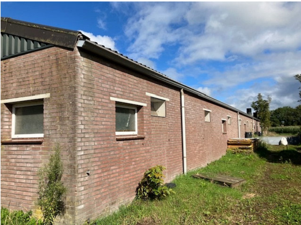
• Afbeelding 10: Zijgevel te slopen stal
