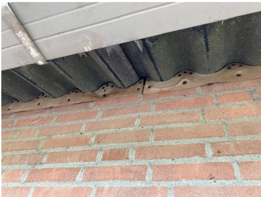
• Afbeelding 18: Onderzijde golfplaten dak, afgewerkt met vogelschroot
