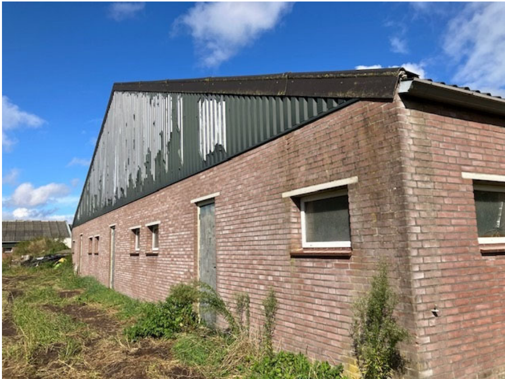
• Afbeelding 9: Achtergevel stal
