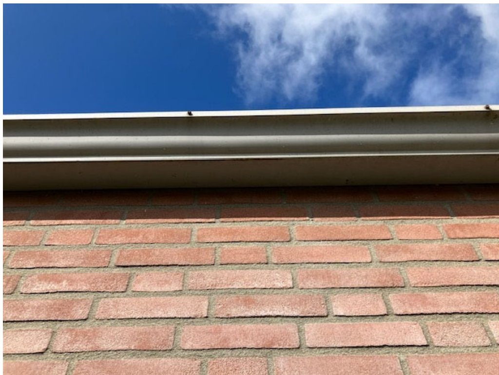
• Afbeelding 8: Detail onderzijde dakgoot, naadloos
