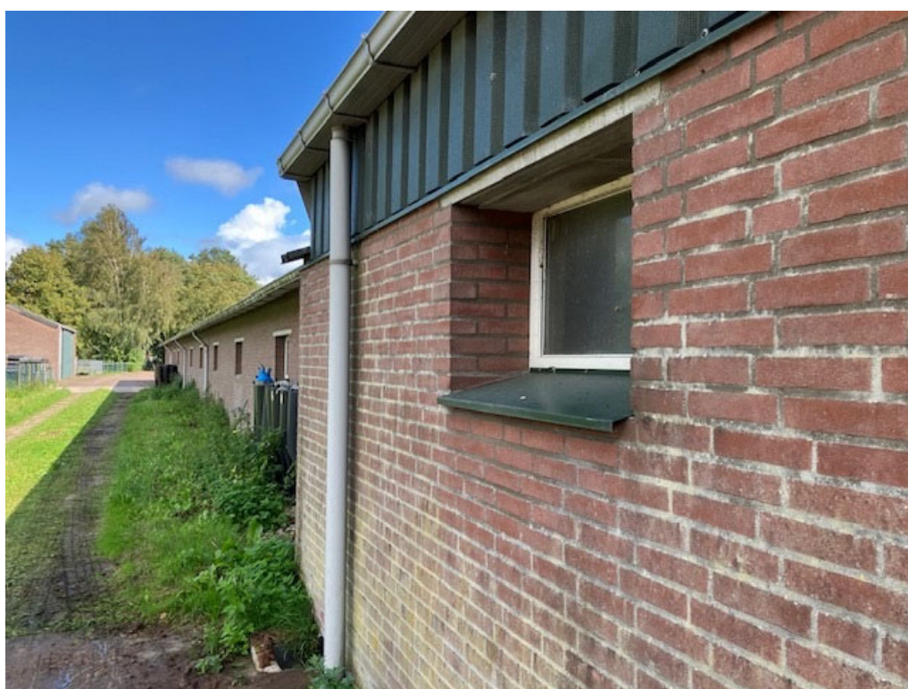
• Afbeelding 17: gevel te slopen varkensstal
