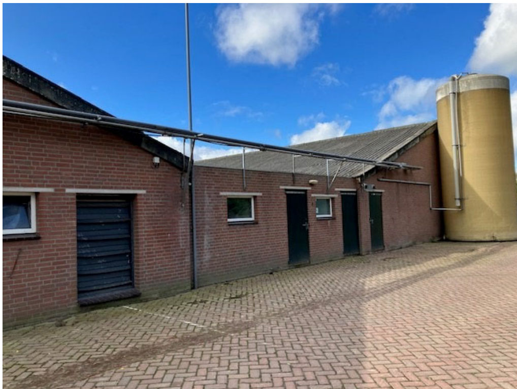
• Afbeelding 4: Voorzijde te slopen stallen
