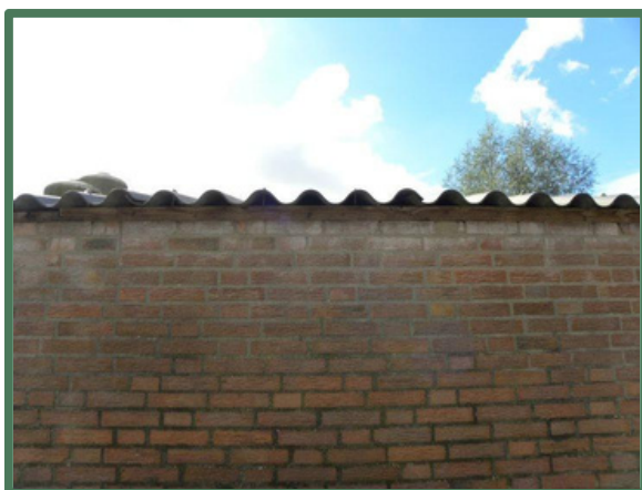
Muurplaat op het dak
