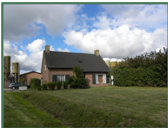
Bedrijfswoning vanaf oosten
