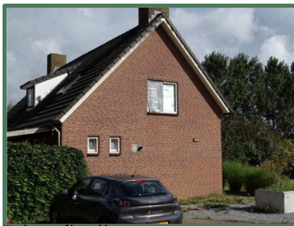
Woning vanaf het zuiden
