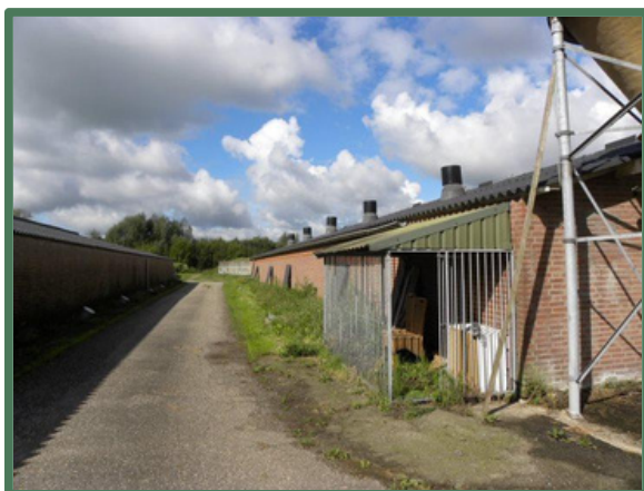
Zuidelijke stal en middelste stal vanaf het oosten
