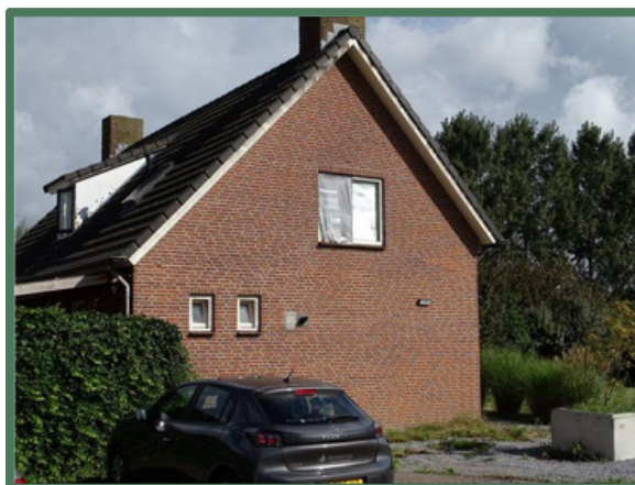
Woning vanaf het zuiden
