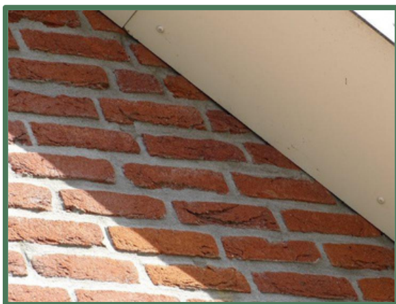
Trespa boeiboord strak aangesloten op de muur
