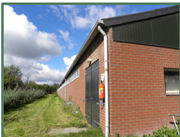
Noordelijke stal vanaf het oosten
