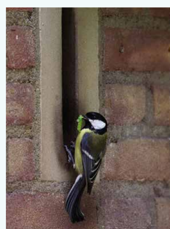
nestkasten en insectenhotel geïntegreerd in de gevel
