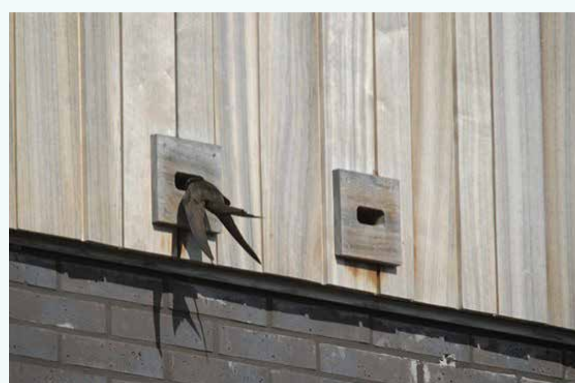
nestkasten en insectenhotel geïntegreerd in de gevel
