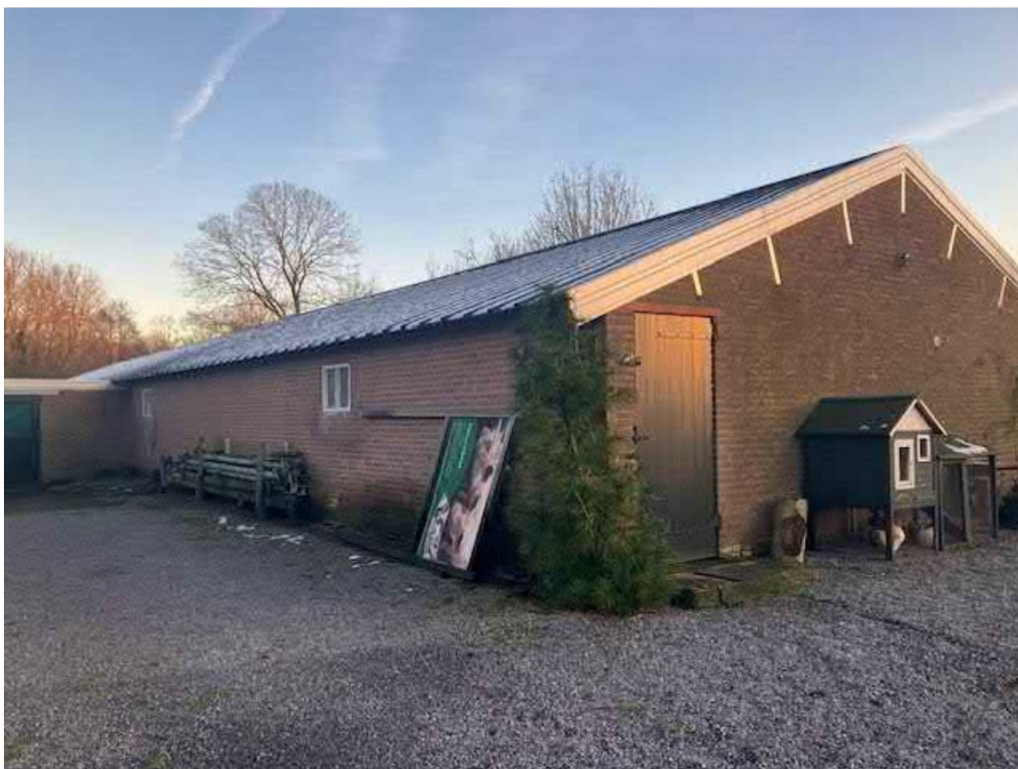
• Afbeelding 16: te slopen stal
