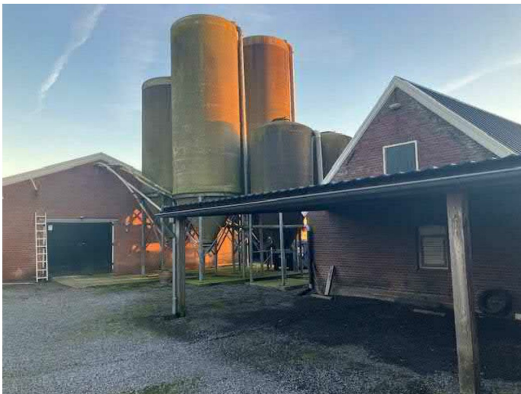
• Afbeelding 12: te slopen stallen
