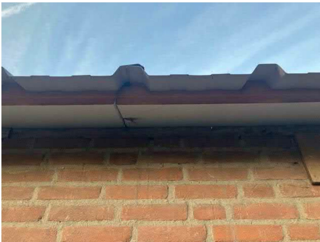
• Afbeelding 18: onderzijde ecopanelen op een houten randbalk
