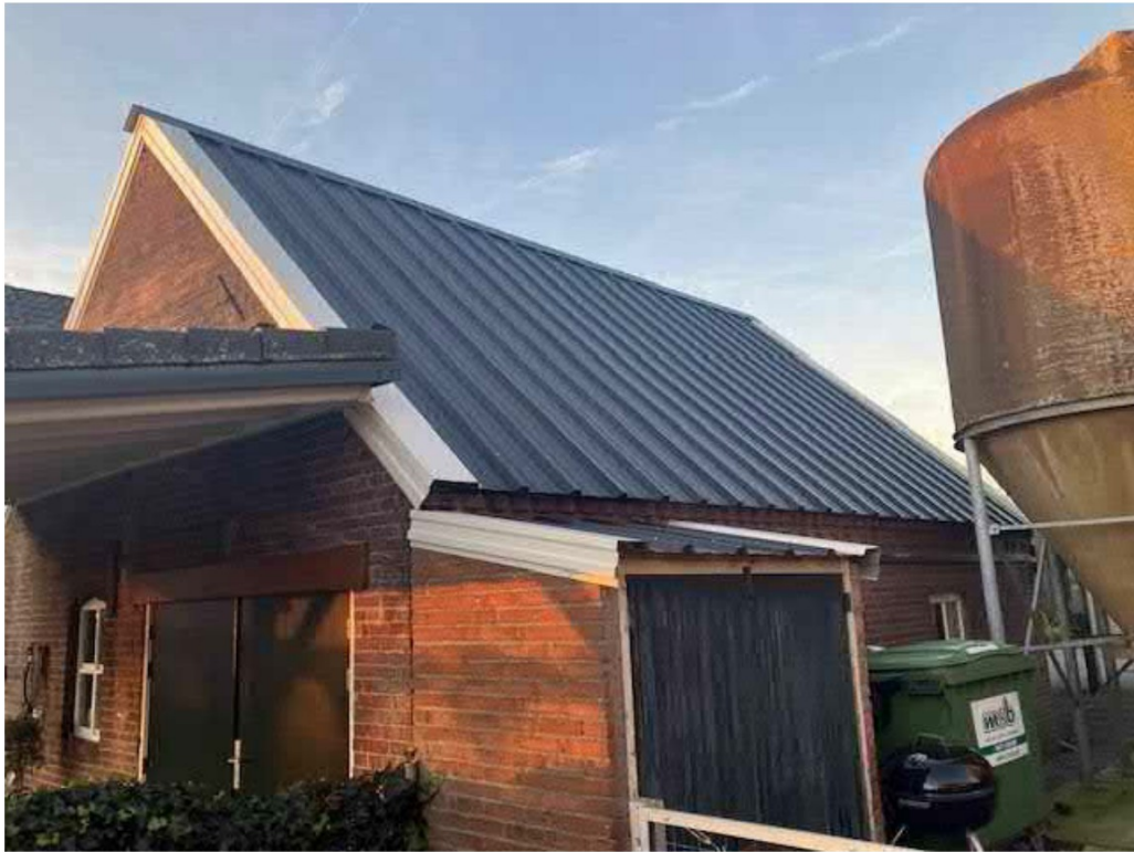
• Afbeelding 14: te slopen garage met overkapping
