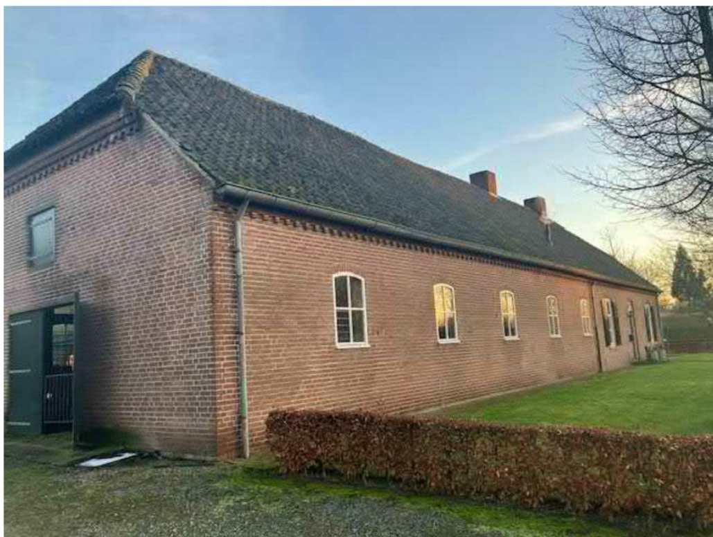
• Afbeelding 9: voorgevel boerderijwoning
