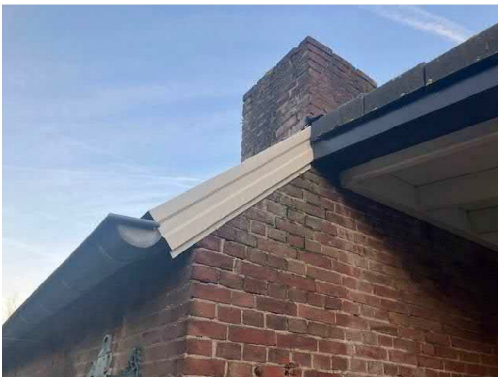
• Afbeelding 13: dakaansluiting van een overkapping bij een te slopen schuur
