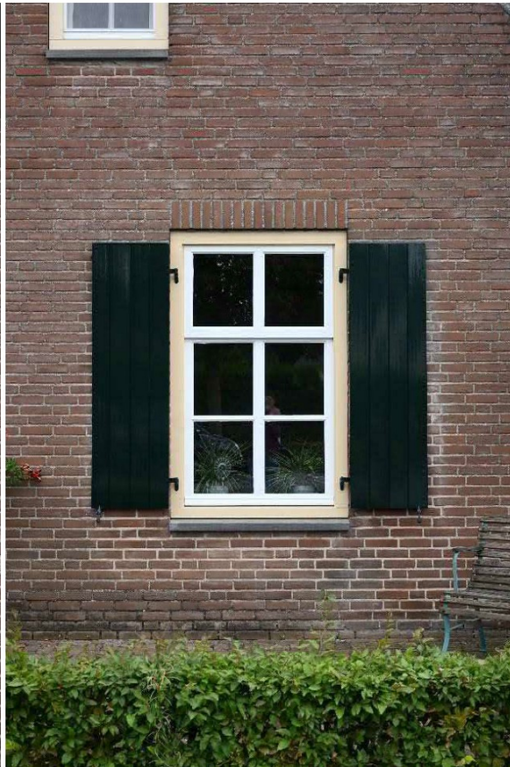
Zesruits venster in de rechter zijgevel.
