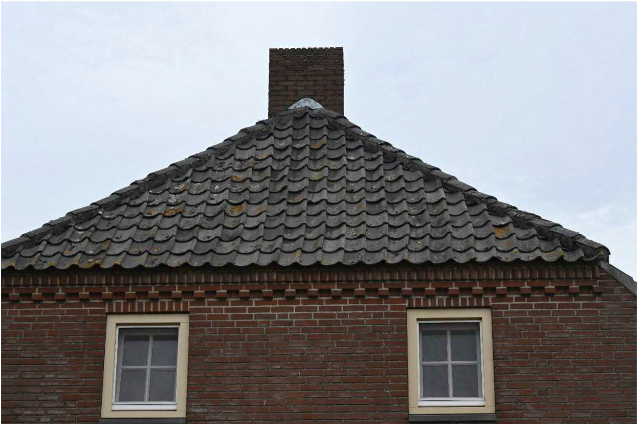
Top van de rechterzijgevel met siermetselwerk in de vorm van een overhoekse muizentand en bloktand onder het wolfeind.
