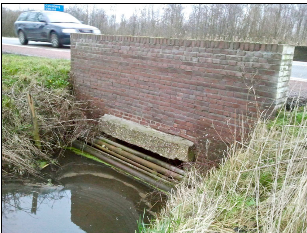
Figuur 5.3 Noordelijke duiker met karakteristieke bakstenen opbouw. De duiker is nu niet passeerbaar voor amfibieën en kleine zoogdieren.
