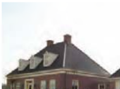
Schilddak met daklijst, dakkapellen,
