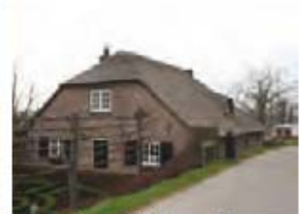
Langsijde aan de dijk (1laag+ kap)
