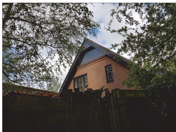
Figuur 6. Kops kant woning vanaf zuiden
