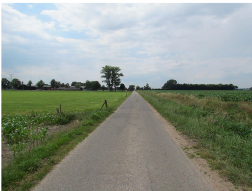
Bokkerijweg (zuidelijk zicht ter hoogte van planlocatie)
