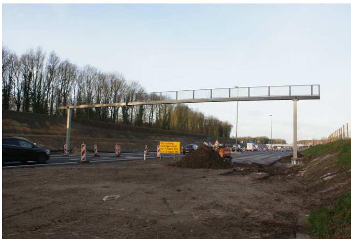
Figuur 4-4: vleermuisportaal (N33, Gieten)
