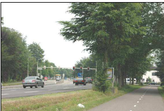
De N348 door Dieren met nabijgelegen bebouwing.
