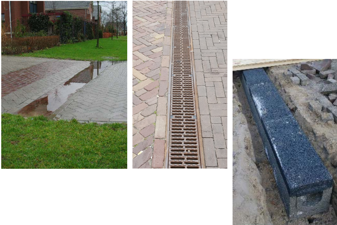
Figuur 3.5 Open goot (links), lijngoot met rooster (midden) en waterdoorlatende betongoot (rechts)
