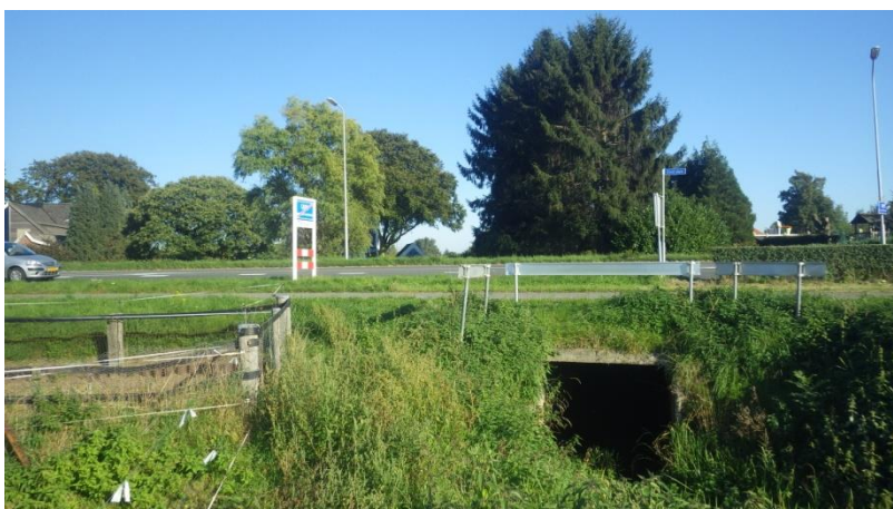
Figuur 15 De overkluizing van de Aa-strang.
