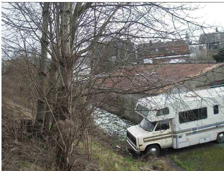
Figuur 3.16 Loods waar in het verleden opslag van kolen plaats heeft gevonden
