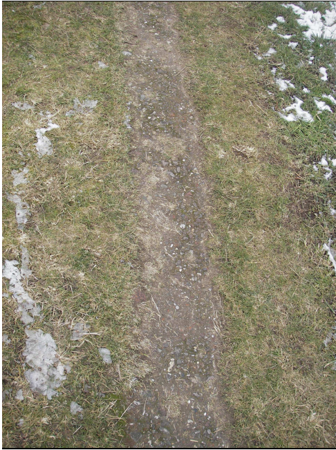
Figuur 3.11 Molenweg met de puin beton verharding
