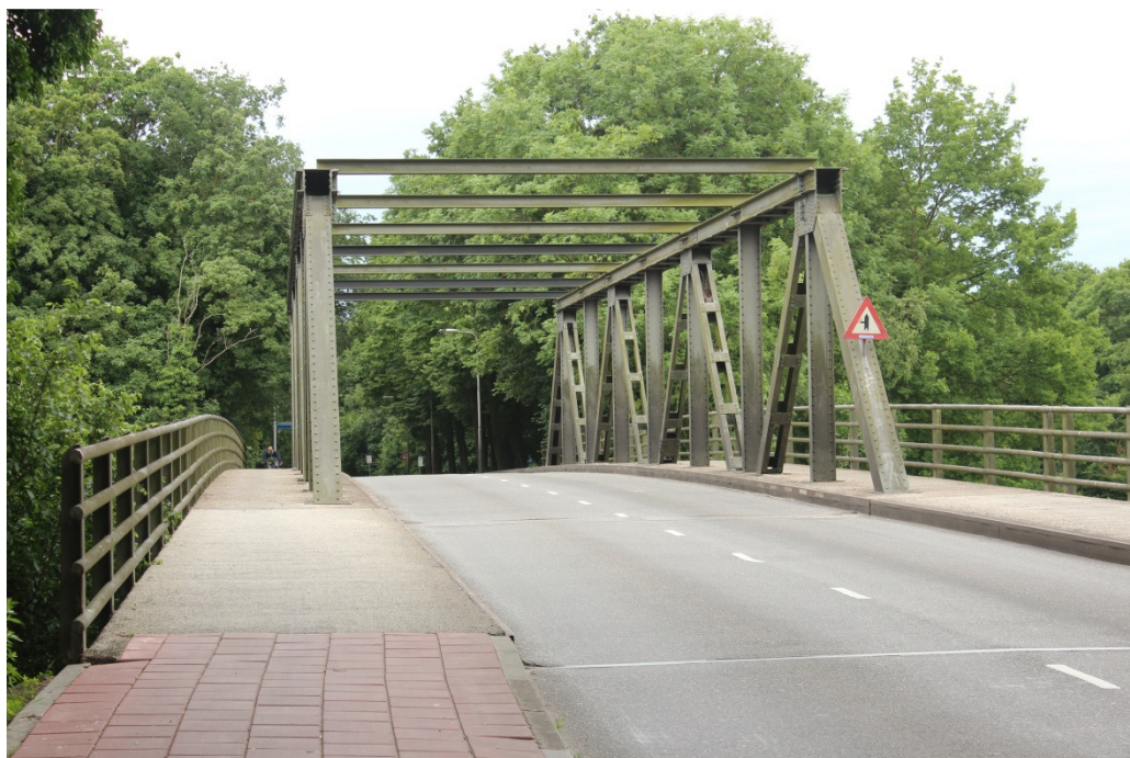
Brug over het Twentekanaal (Stationsweg)
