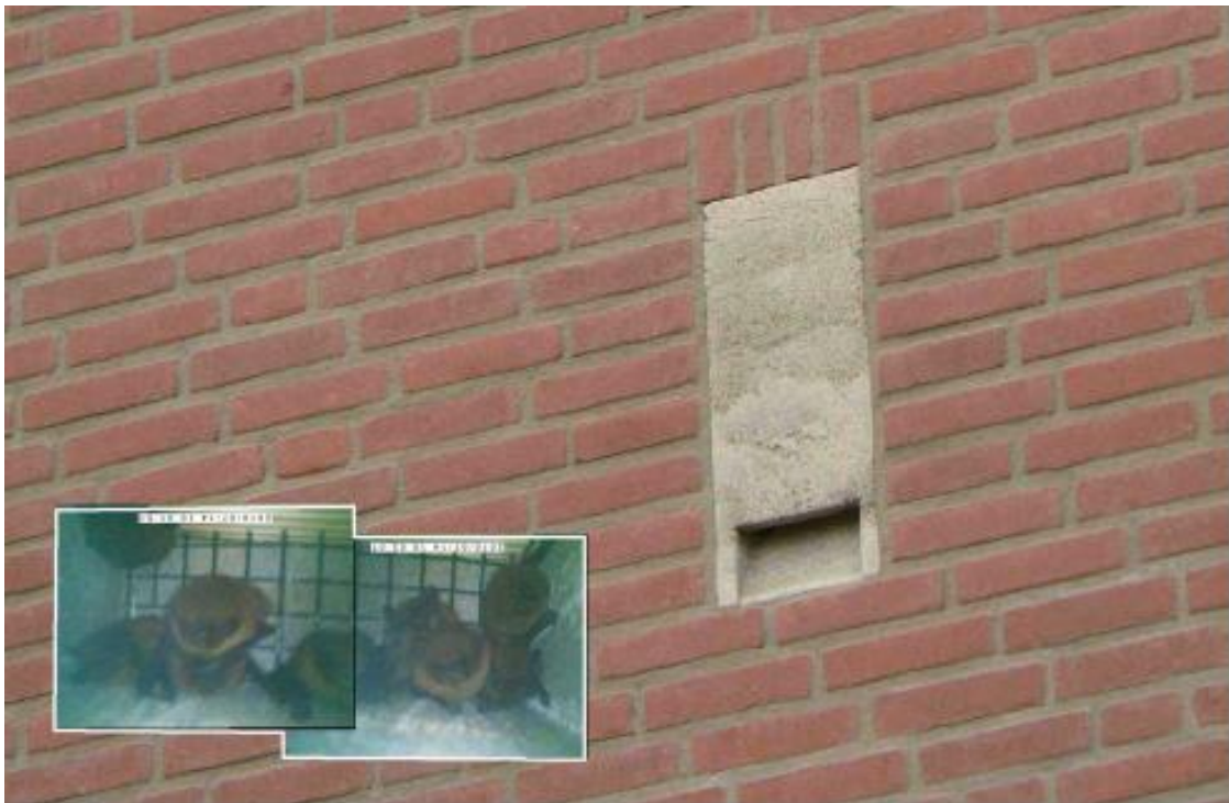
Figuur B2.3 - Visualisatie van een inwendig permanente verblijfplaats voor vleermuizen (foto uit Korsten 2012).
