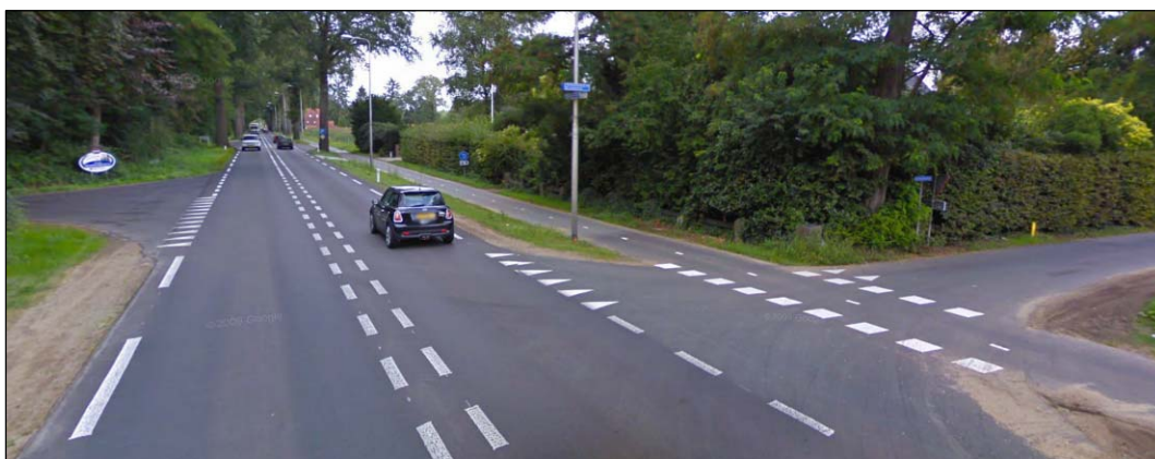
Figuur 3: Noordelijk deel plangebied, ter hoogte van kruispunt Jodendijk/Scheuterdijk in noordelijke richting (bron: Google Streetview)
