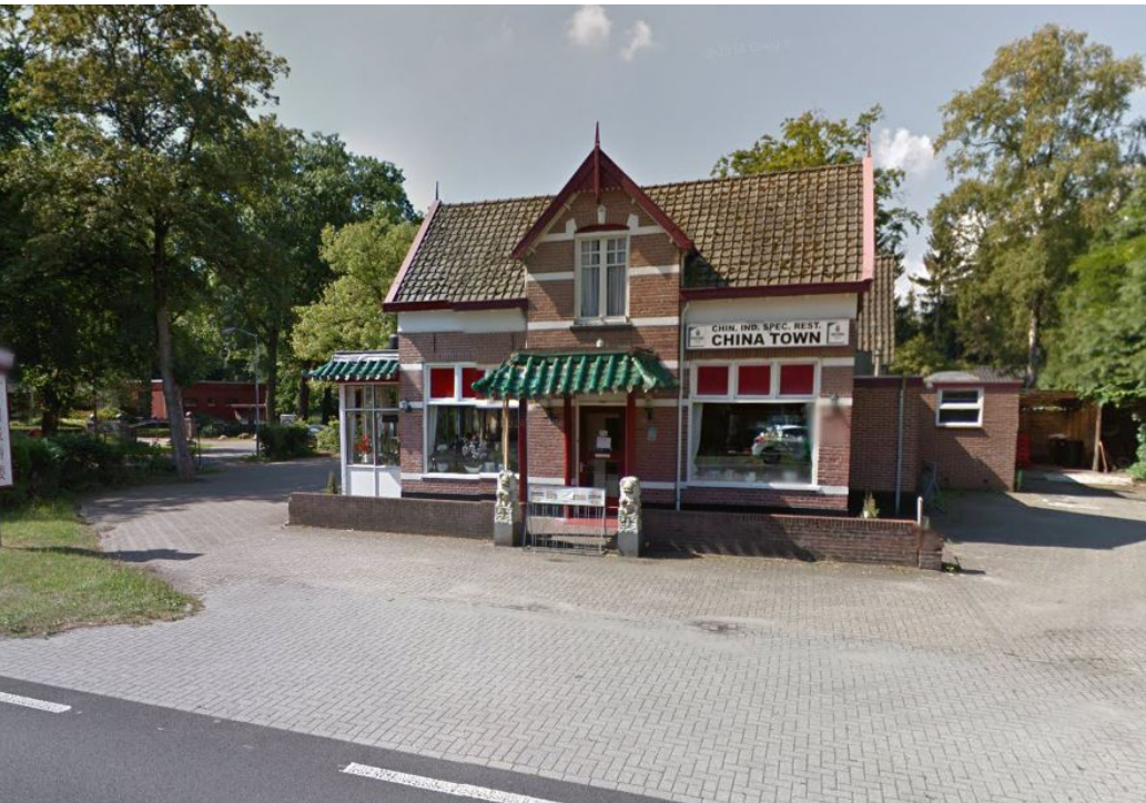
Advies: beter landschappelijk inpassen met groenstrook en/of haag. Kruising moet ruimtelijk en functioneel 'los komen' van de buitenruimte van het restaurant.
