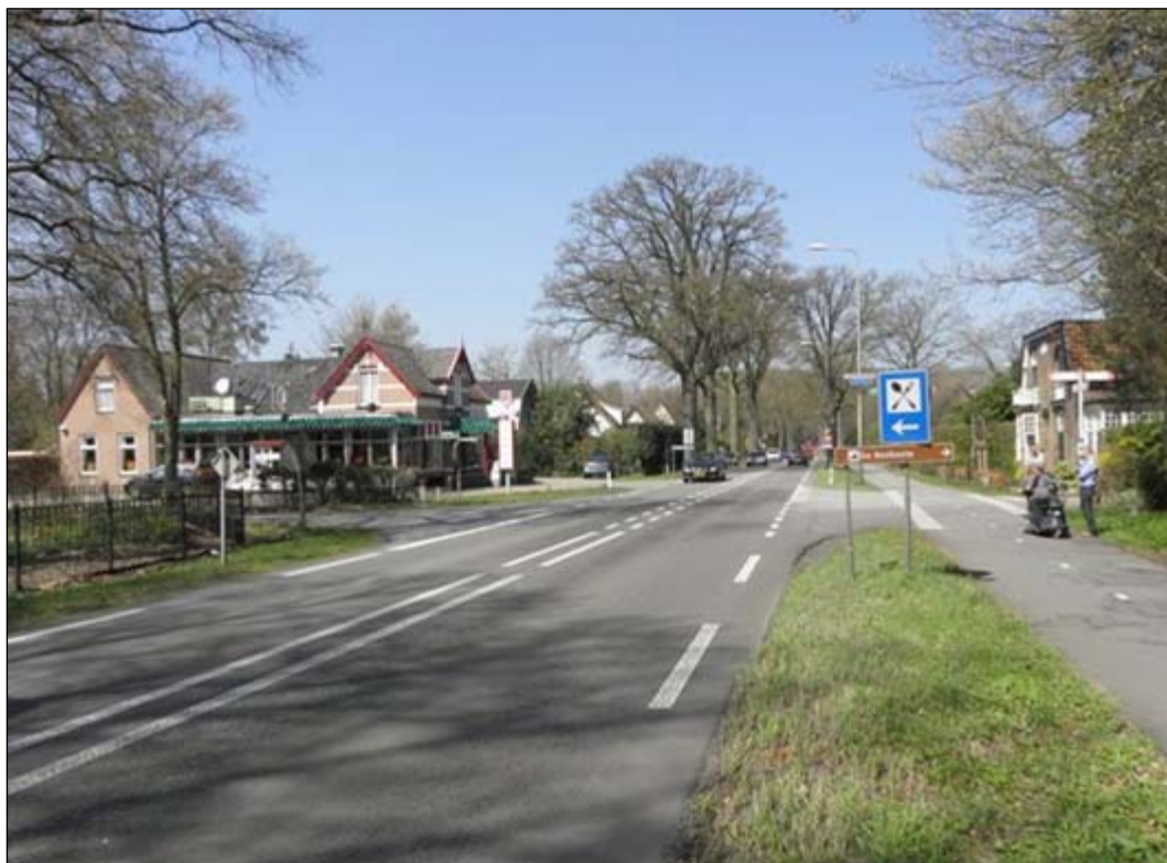
Figuur 4: Foto van de kruising Quatre Bras, genomen in noordwestelijke richting (bron: Kruising N348- Quatre Brasweg / Flierderweg - Verkenning naar de best passende kruispuntvorm, Grontmij, 2014)
