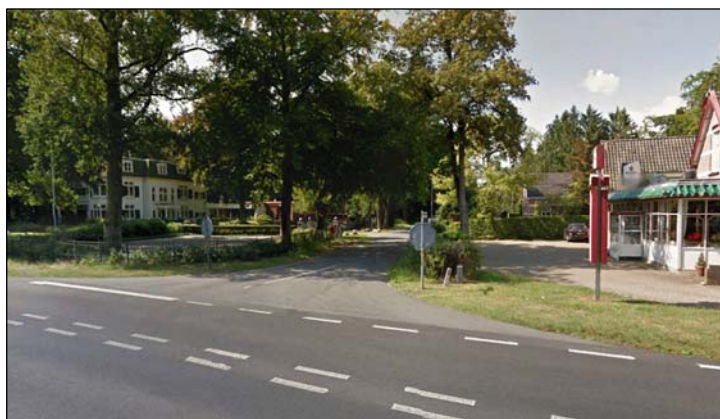
Figuur 5: De aansluiting van de N348 met de Quatre Brasweg, met aan de rechterzijde het Chinees restaurant en aan de linkerzijde het kantoorgebouw met bijbehorende parkeervoorziening (bron: Google Streetview)
