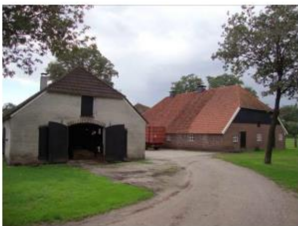
Afb. 1.10: Boerderij Morgenstern langs de Ruïnelaan.
