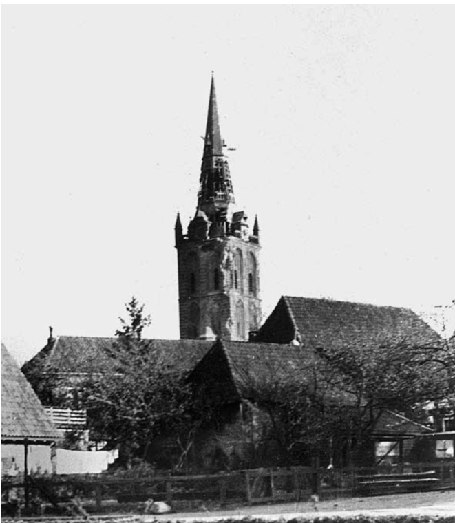
Afbeelding 2: De beschadigde toren van de Gudulakerk te Lochem. (Bron Land van Lochem 2015 nr.1)
