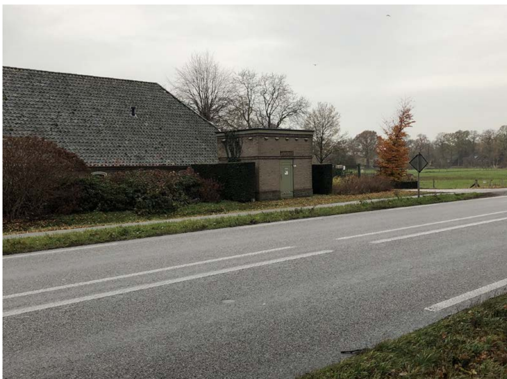
Foto 1: Traforuimte ten behoeve van elektra voorziening.
