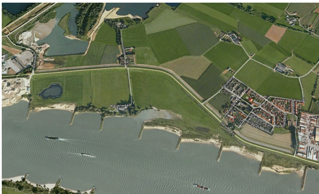
Figuur 1: Overzicht Beijenwaard (Bron: Google earth)
