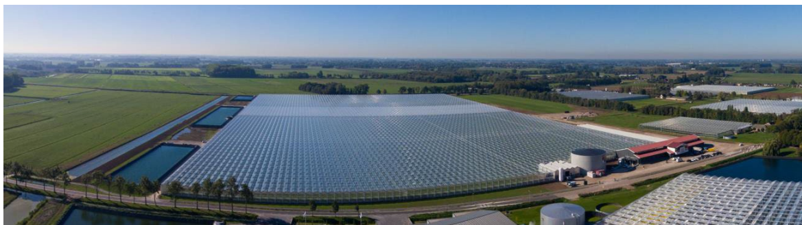
Afbeelding: luchtfoto eerste bouwfase Dutch Berries
