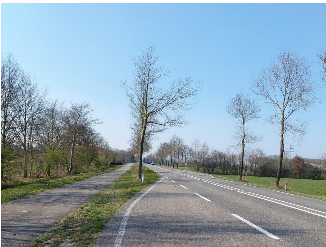
Afbeelding 3a: Impressiefoto van het traject N825 tussen de Banemansdijk en Wolvenveldsweg. Situatie op 25-3-2022.
