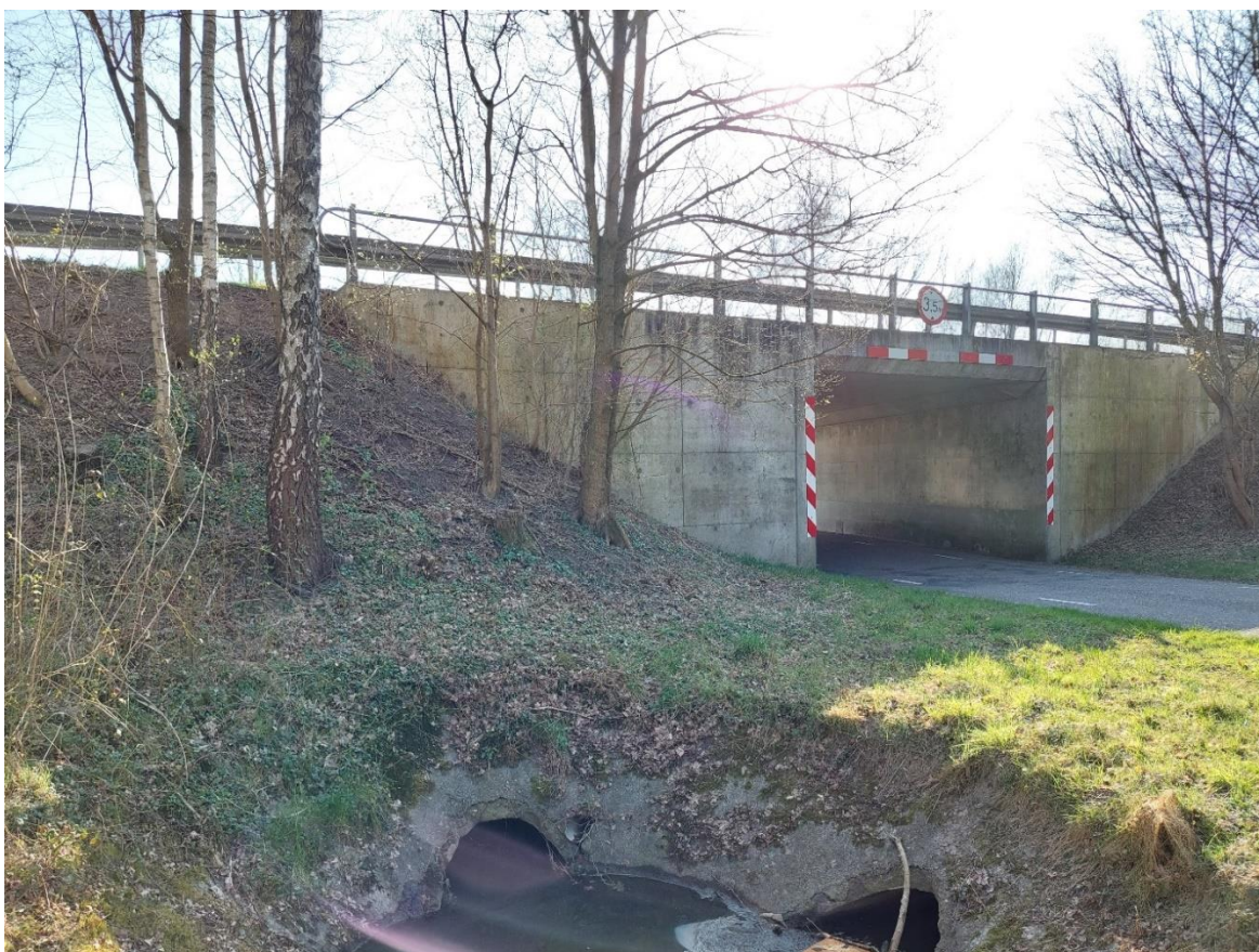
Afbeelding 3e: Het viaduct in het plangebied. Situatie op 24-3-2022.
